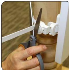
Après avoir coupé la sangle, à l'aide de l'outil de desserrage, desserrer l'écrou, jusqu'à ce que l'extrémité de la sangle soit protégée par l'écrou de serrage, puis vérifier de nouveau la solidité de l'ensemble prêt à monter pour escalier.
