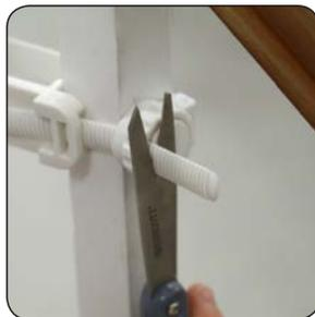
Après avoir coupé la sangle, à l'aide de l'outil de desserrage, desserrer l'écrou, jusqu'à ce que l'extrémité de la sangle soit protégée par l'écrou de serrage.
