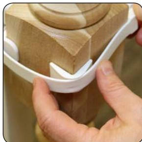
À la main, visser l'écrou de serrage le plus possible, puis utiliser l'outil de serrage pour fixer l'ensemble prêt à monter au poteau.
